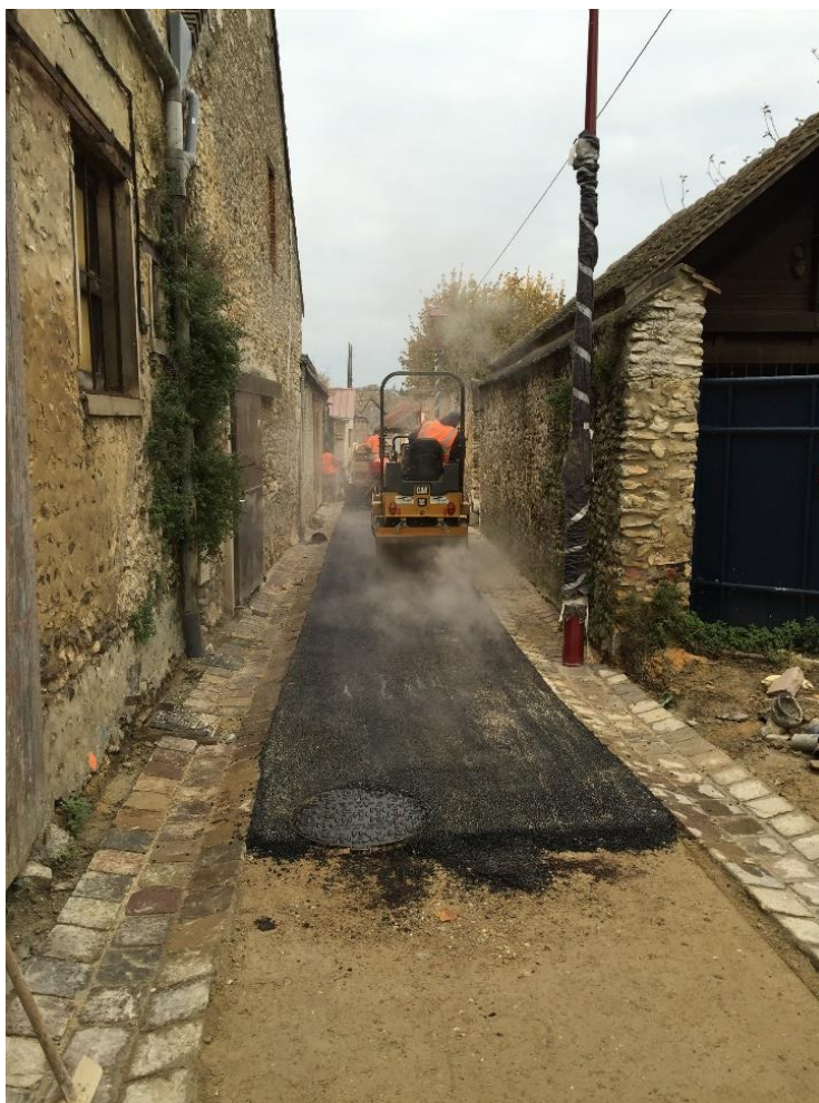
Illustration. Exemple de la réfection de la Rue des Fossés, décembre 2015. Source interne.
