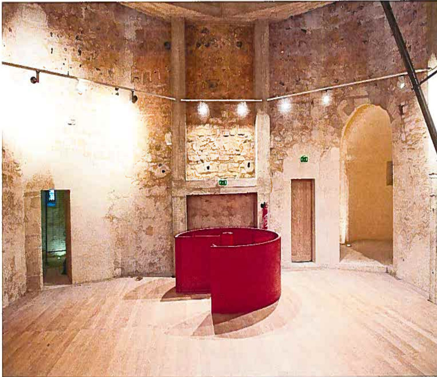
La Salle Amaury III (niveau 2) terminée. De gauche à droite, la baie E, entrée de la tourelle N-E, le nouvel escalier circulaire puis les baies A et B entièrement reprises. Devant, le nouveau plancher en chêne sur ossature métallique. Au centre, poteaux de la cuve.
