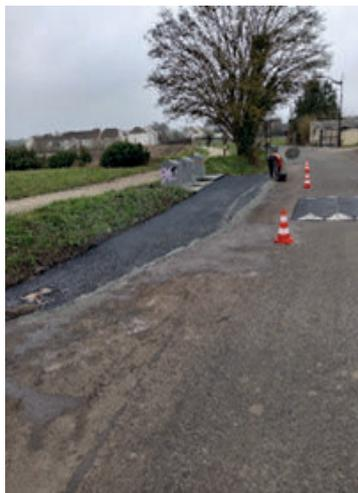
L'accotement et le drain permettant d'évacuer les eaux pluviales le long des conteneurs enterrés route de Champagne ont dû être refaits. Cette réparation va ainsi éviter que l'eau de pluie ne vienne se déverser dans les conteneurs, les rendant inutilisables, et va faciliter l'accès des riverains usagers et du SIEED. Cette réparation imprévue mais nécessaire a coûté 9 550 € TTC.
